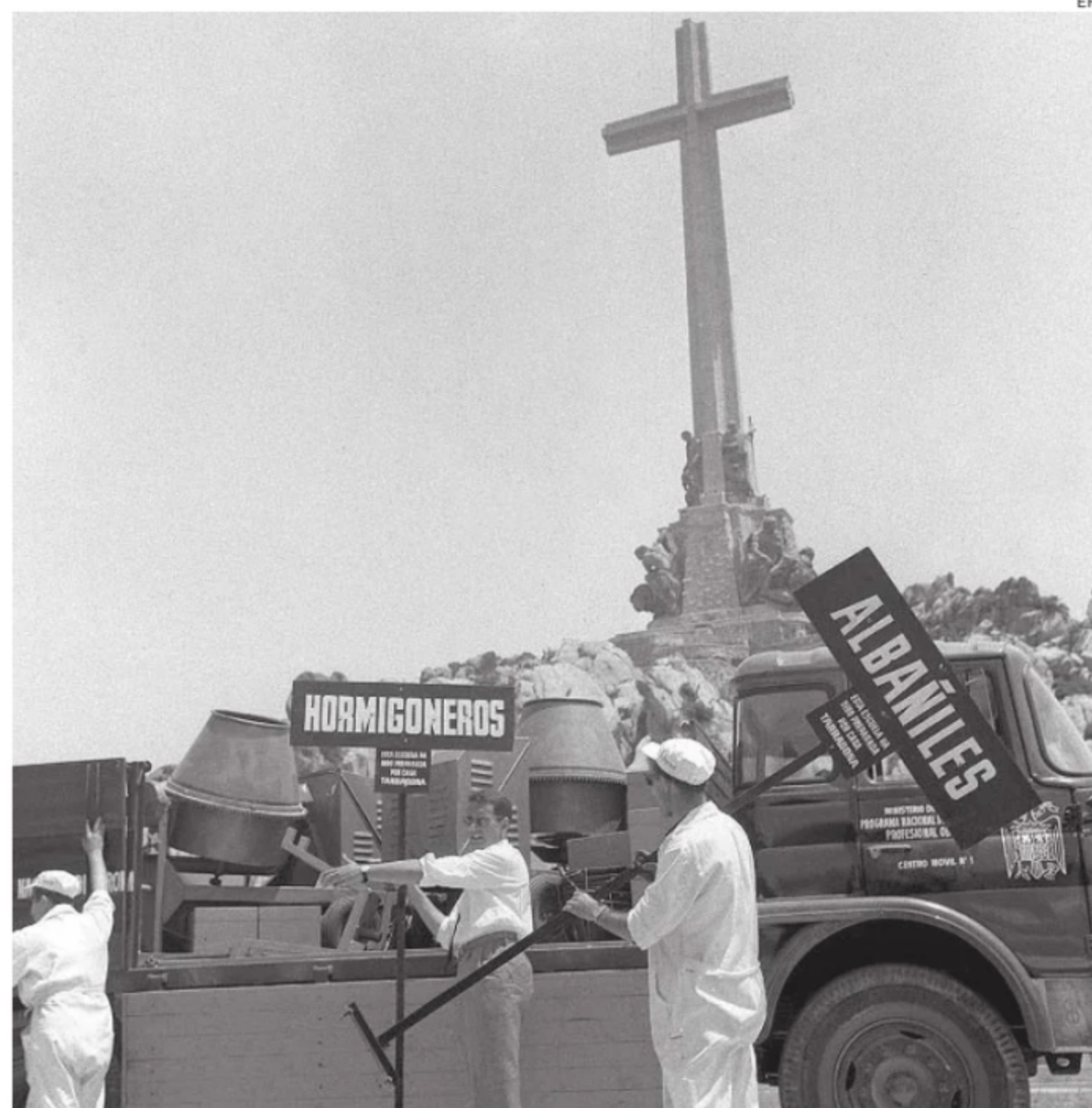
Operarios descargan la maquinaria de obra para construir el funicular del Valle
